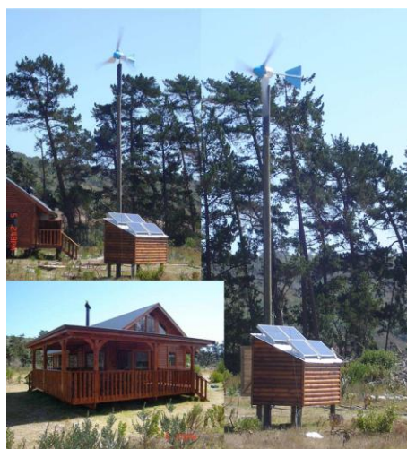
Des éoliennes ensite isolé
