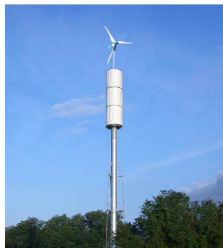
Une éolienne montée sur un mât de télécom.
